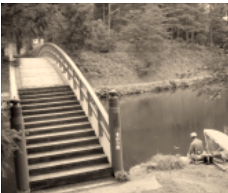
赤い橋ポイント。橋の両サイドが絶好のポイントこの橋を渡り、右に進めば環堤ポイントで、左に進むと桜並木ポイントだ。また、この上の山にはバラ園があり開花時にはたくさんの方が訪れます。
